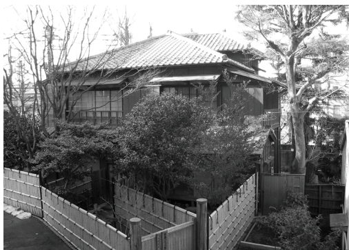
解体移築が決まった成瀬記念館分館
